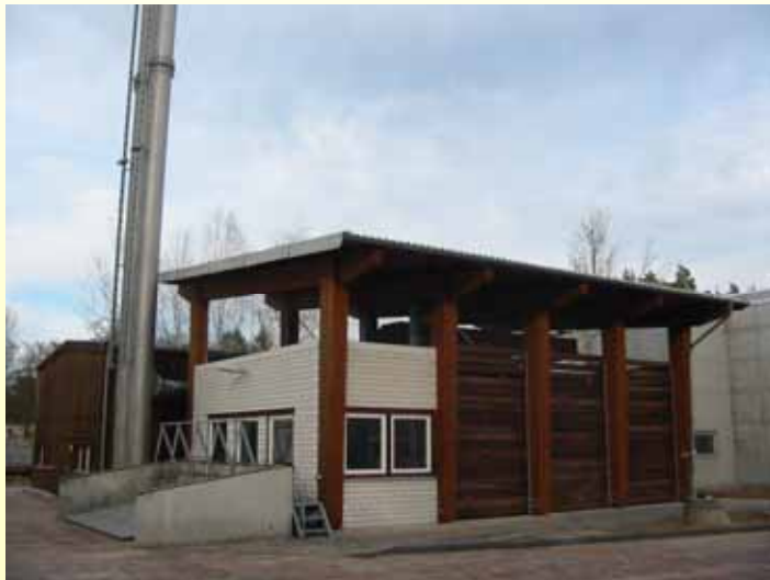
Heizanlage mit Hackschnitzellager
