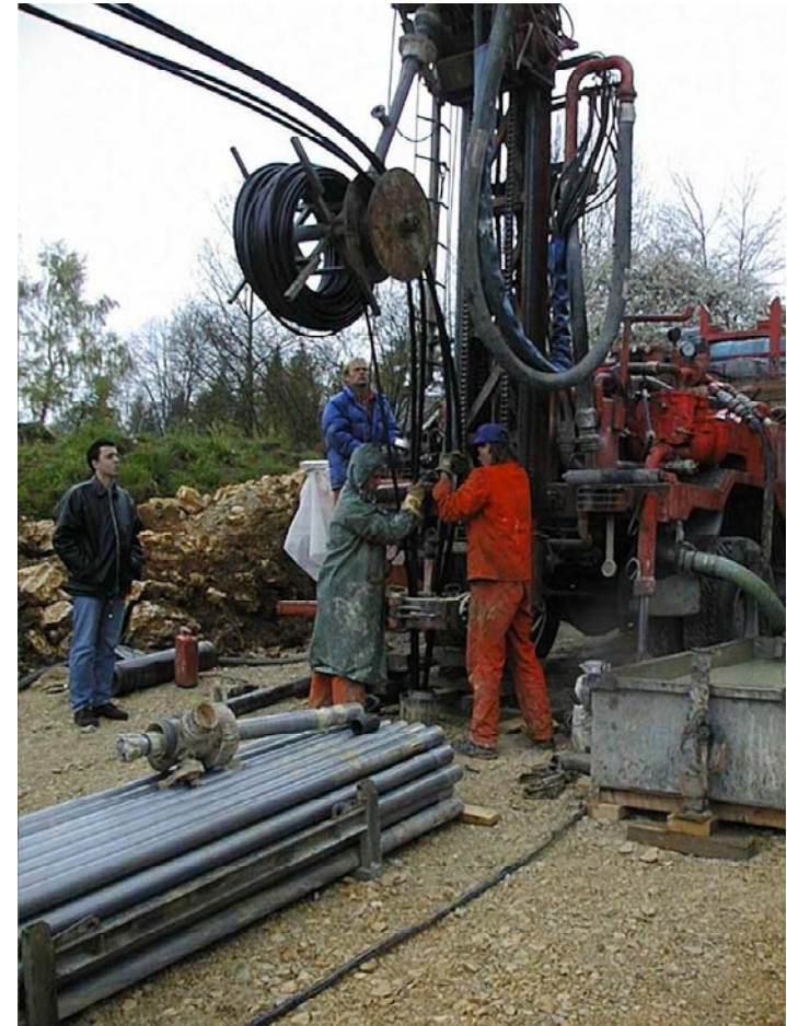
EWS-Bohrung und -Installation
