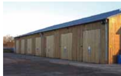
Abb. 1: Garagen-Trockenfermentationsanlage Siemke in Breese
